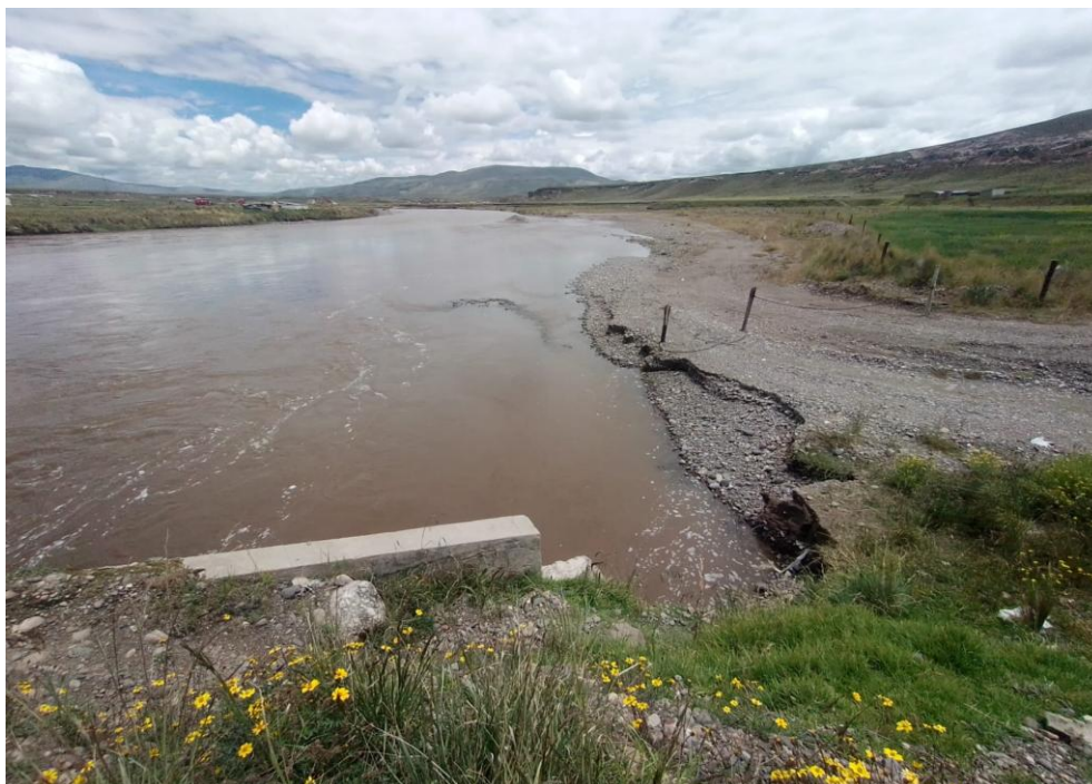
IMAGEN 02: SE OBSERVA EROSION LATERAL EN LA MARGEN DERECHA DEL RIO, VULNERABLE A EVENTOS DE MAXIMA AVENIDA
